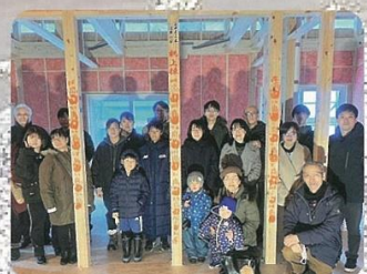
会堂建設中「手形式」柱に各自手形を捺す 2022年12月11日
